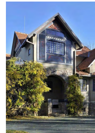
JURKOVIČOVA VILA, MORAVSKÁ GALERIE V BRNĚ
